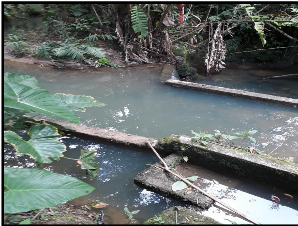
Figura 33 – Bocatoma sobre la quebrada El Orozco
