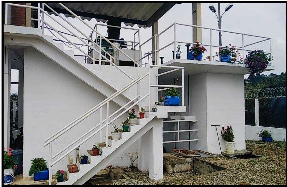
Figura 37 – Planta de tratamiento de agua potable de Nátaga
