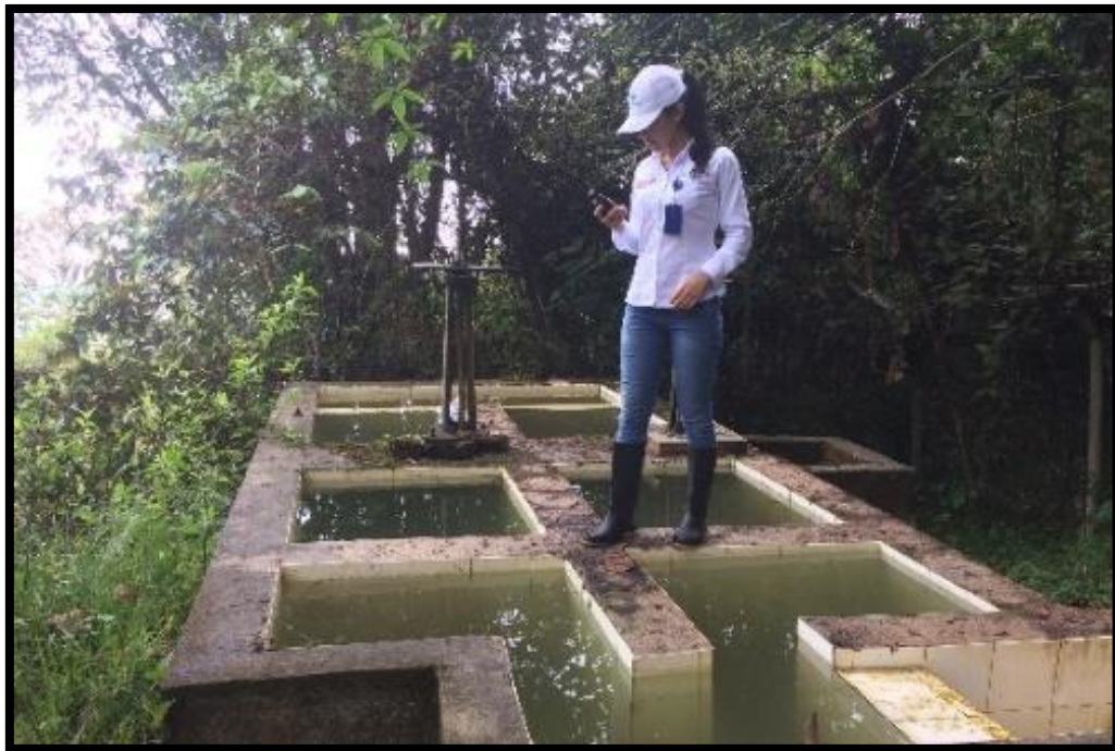
Figura 6 – Desarenador sobre aducción quebrada El Lindero
