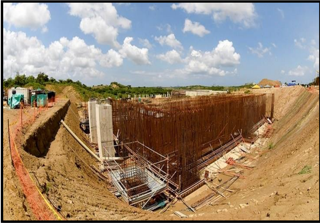
Figura 8 – Tanque de almacenamiento acueducto de Nátaga en construcción
