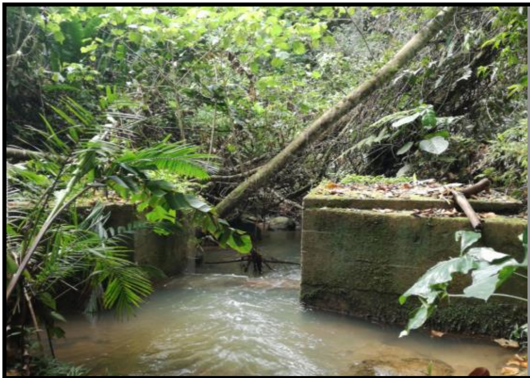
Figura 5 – Bocatoma sobre la quebrada El Orozco
