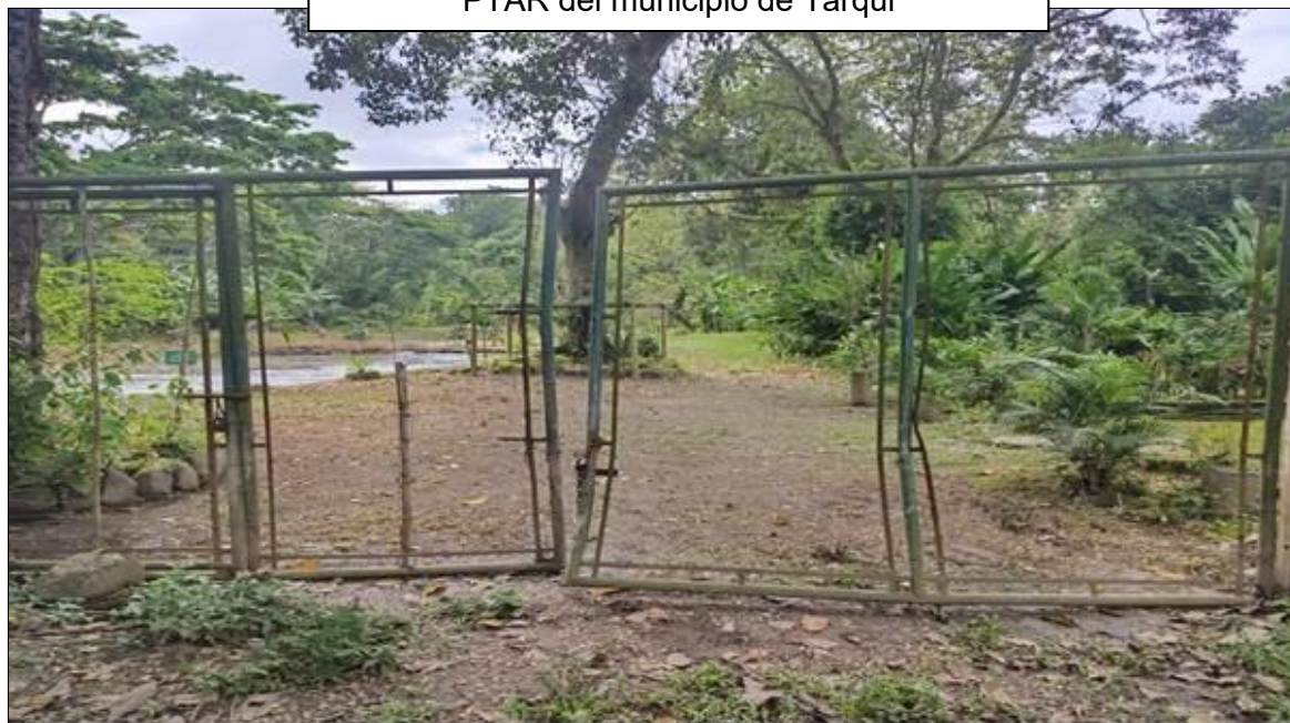
PTAR del municipio de Tarqui
