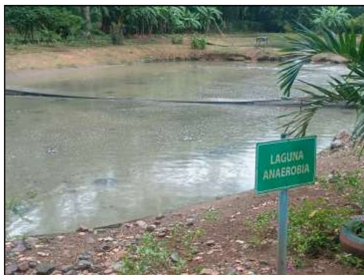
Figura 6. Laguna Anaerobia en PTAR Zapatero-Municipio de Tarqui
