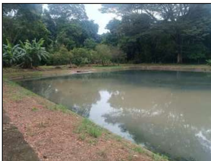
Figura 8. Laguna Facultativa en PTAR Zapatero-Municipio de Tarqui
