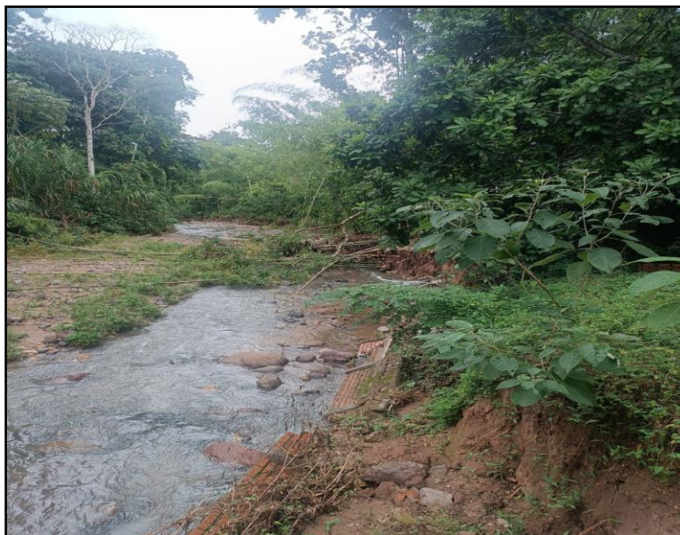
Figura 13. Vertimiento final en PTAR Zapatero- Municipio Tarqui Huila
