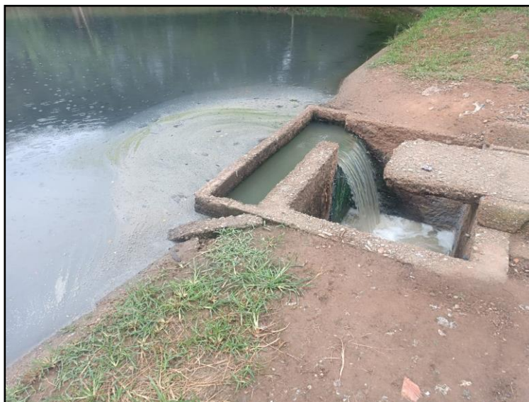
Figura 9. Interconexión de flujo entre lagunas en PTAR Zapatero- Municipio de Tarqui Huila
