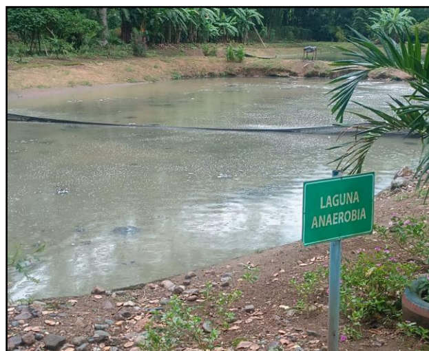
Figura 8. Laguna Anaerobia en PTAR Zapatero- Municipio de Tarqui Huila
