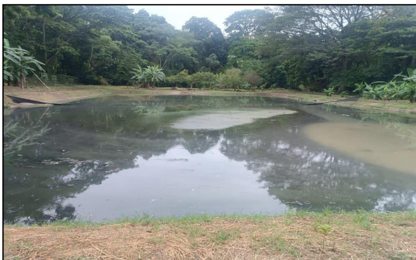
Figura 10. Laguna Facultativa en PTAR Zapatero- Municipio de Tarqui Huila
