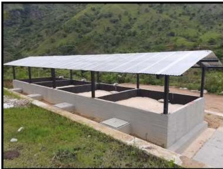
Figura 28. Lechos de secado de lodos en PTAR La Nueva Santa María
