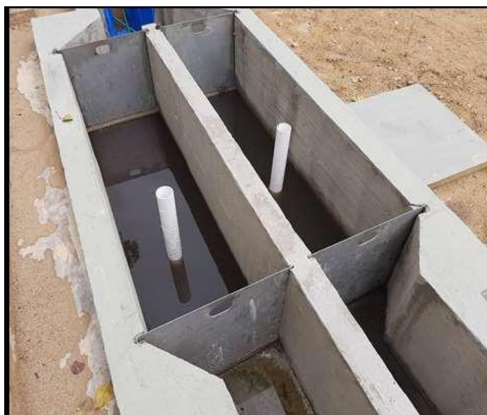
Figura 4. Unidades para desarenado en PTAR principal Santa María.
