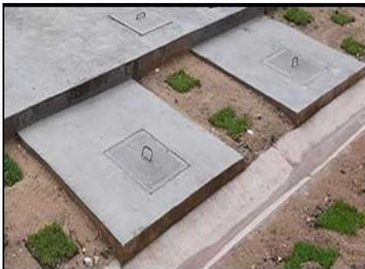
Figura 25. Cajilla de válvulas de lodos del RAFP y FAFA en PTAR La Nueva Santa María
