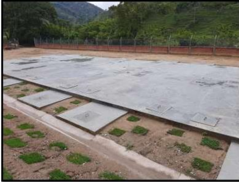
Figura 8. Reactores anaerobios de flujo pistón – RAFP en PTAR principal Santa María
