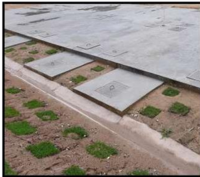
Figura 9. Cajilla de válvulas de lodos del RAFP y FAFA en PTAR principal Santa María
