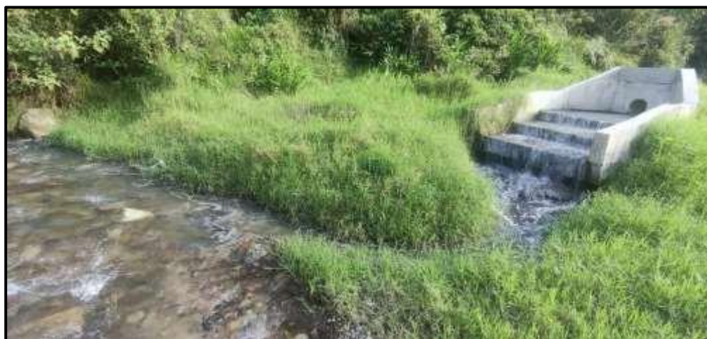
Figura 16. Vertimiento de aguas tratadas a río Baché, en PTAR Principal Santa María
