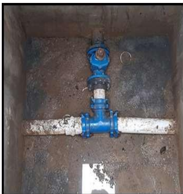
Figura 25. Cajilla de válvulas de lodos del RAFP y FAFA en PTAR La Nueva Santa María
