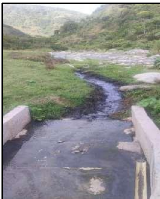
Figura 29. Vertimiento de aguas tratadas a río Baché, en PTAR La Nueva Santa María
