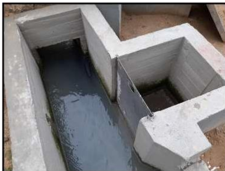
Figura 2. Aliviadero inicial de aguas crudas en PTAR principal Santa María
