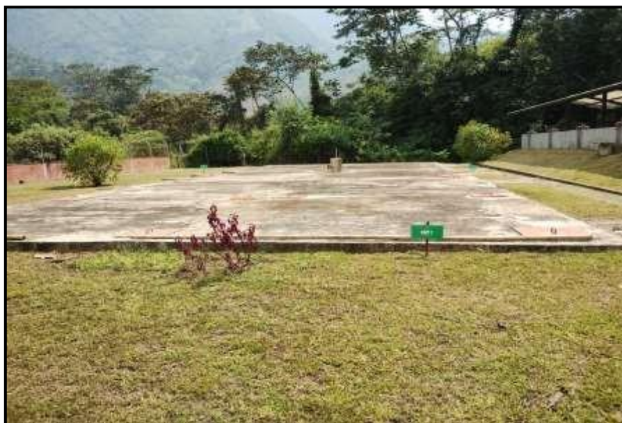
Figura 12 - Reactores anaerobios de flujo pistón – RAFP en PTAR Santa María Principal
