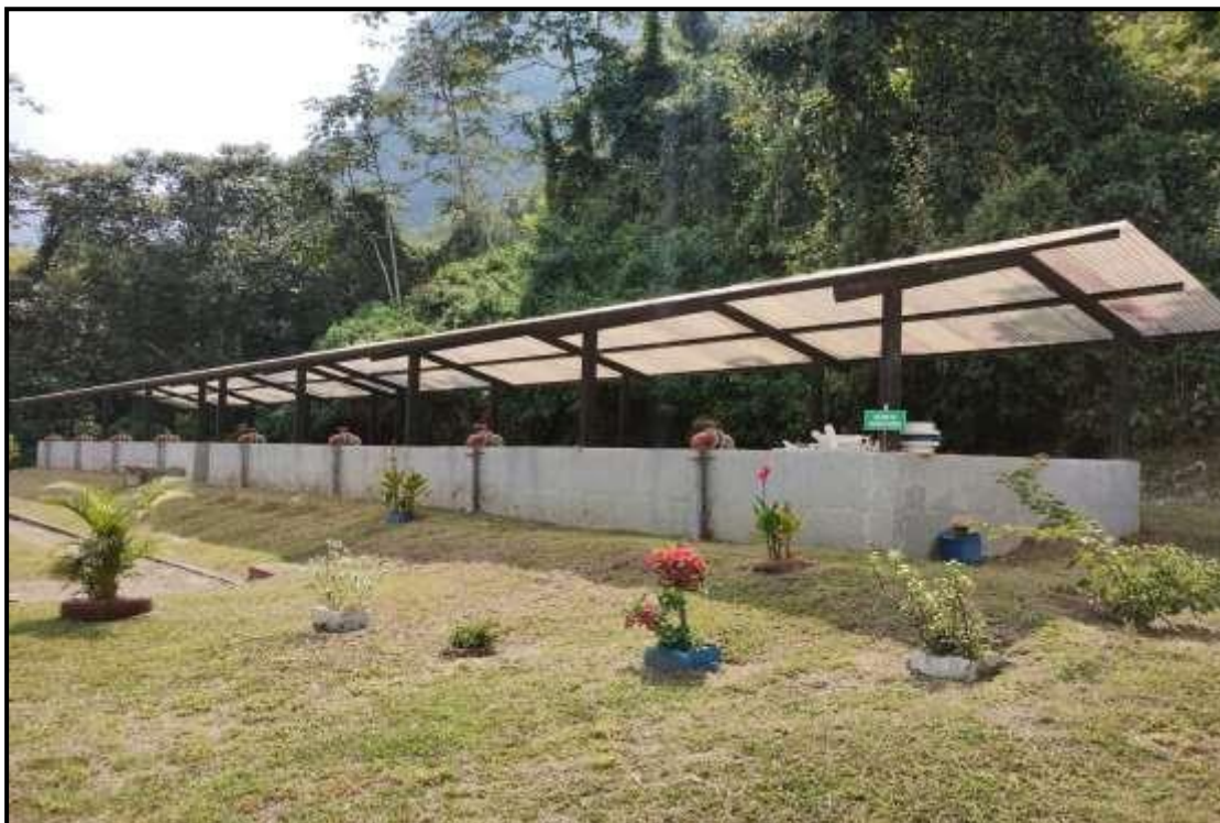
Figura 17 – Lechos de secado de lodos en PTAR Santa María Principal
