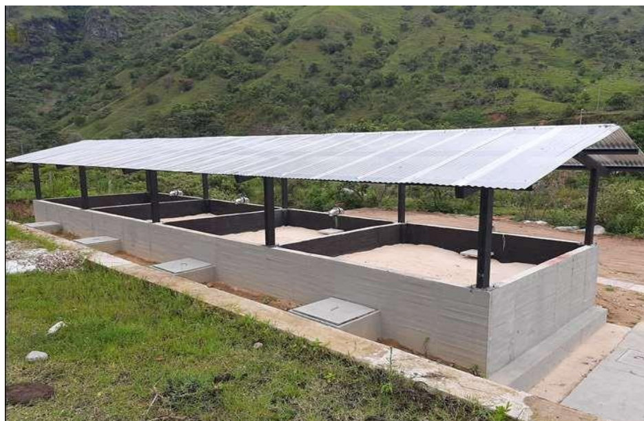
Figura 30 – Lechos de secado de lodos en PTAR Santa María La Nueva
