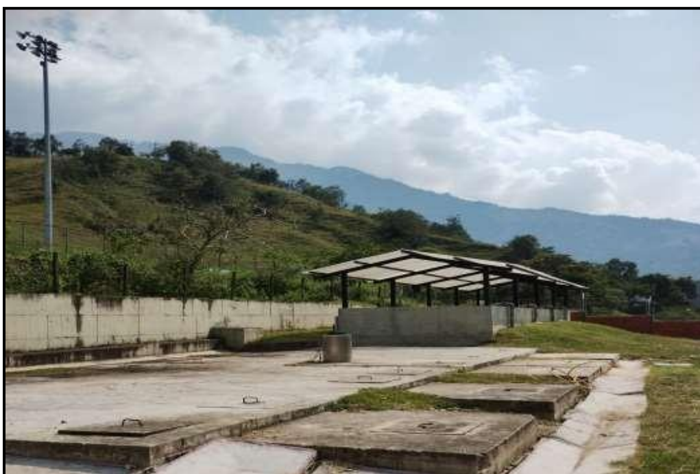
Figura 28 – Filtros anaerobios de flujo ascendente FAFA en PTAR Santa María La Nueva
