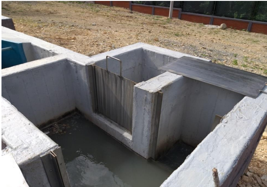
Imagen 7 Aliviadero intermedio de aguas con pretratamiento
