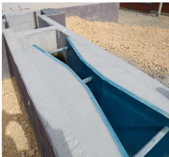
Imagen 6 Aforador de caudal – canaleta parshall de 6” de garganta
