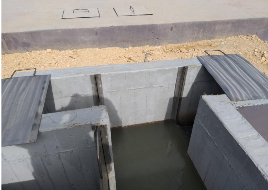
Imagen 8 Canal de repartición de caudales con sus respectivas compuertas
