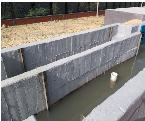
Imagen 5 Unidades para desarenado en paralelo, incluye compuertas de aislamiento y válvulas
