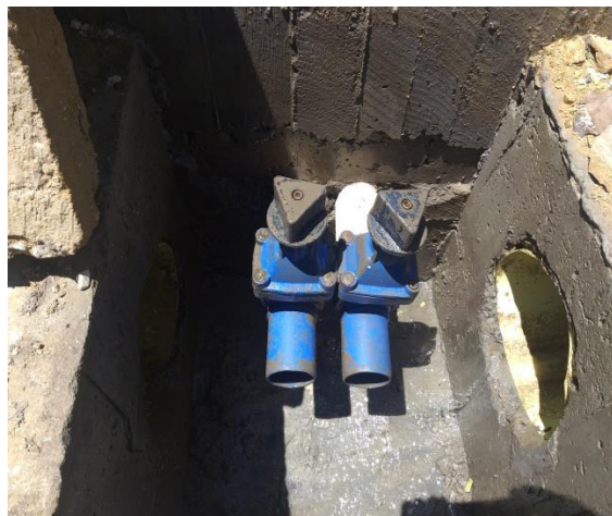
Imagen 5 Unidades para desarenado en paralelo, incluye compuertas de aislamiento y válvulas
