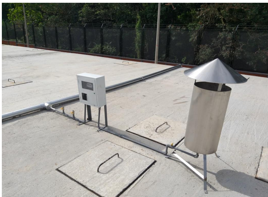
Imagen 13 Unidad quemadora de biogás en PTAR Paicol
