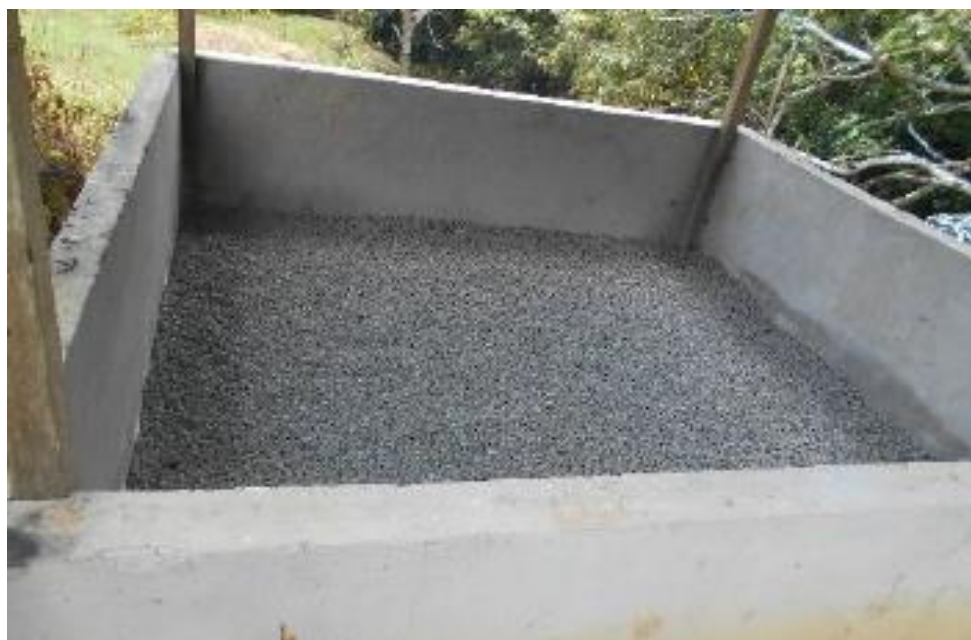
Figura 14. Lecho de secado de lodos en PTAR Tinajitas Nátaga
